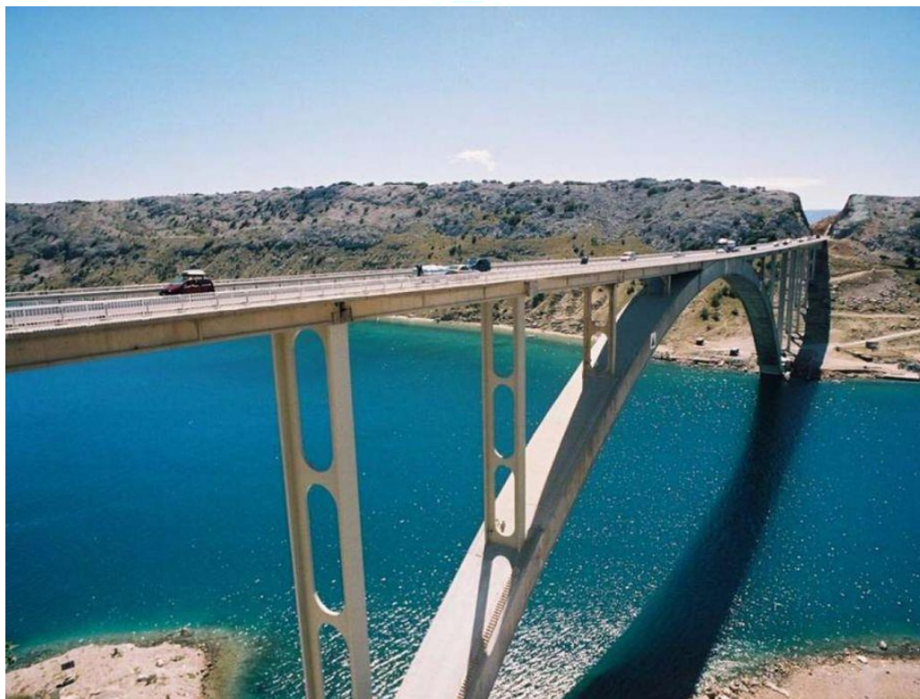
Fot. 23 (Internet) – most na wyspę Krk (Krčki most) łączy wyspę z lądem
